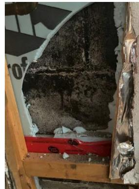
Moisissures sur le mur de fondation en solage de bloc
