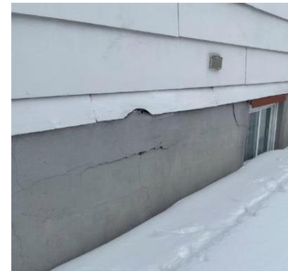
Fondation fissurée en cisaillement, faiblesse majeure aux charges sismiques
