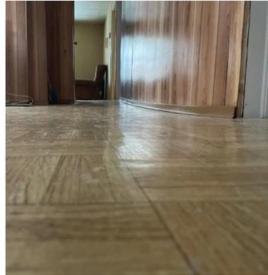
Fléchissement du plancher vis-à-vis le mur porteur au RDC et poutre et sous-sol
