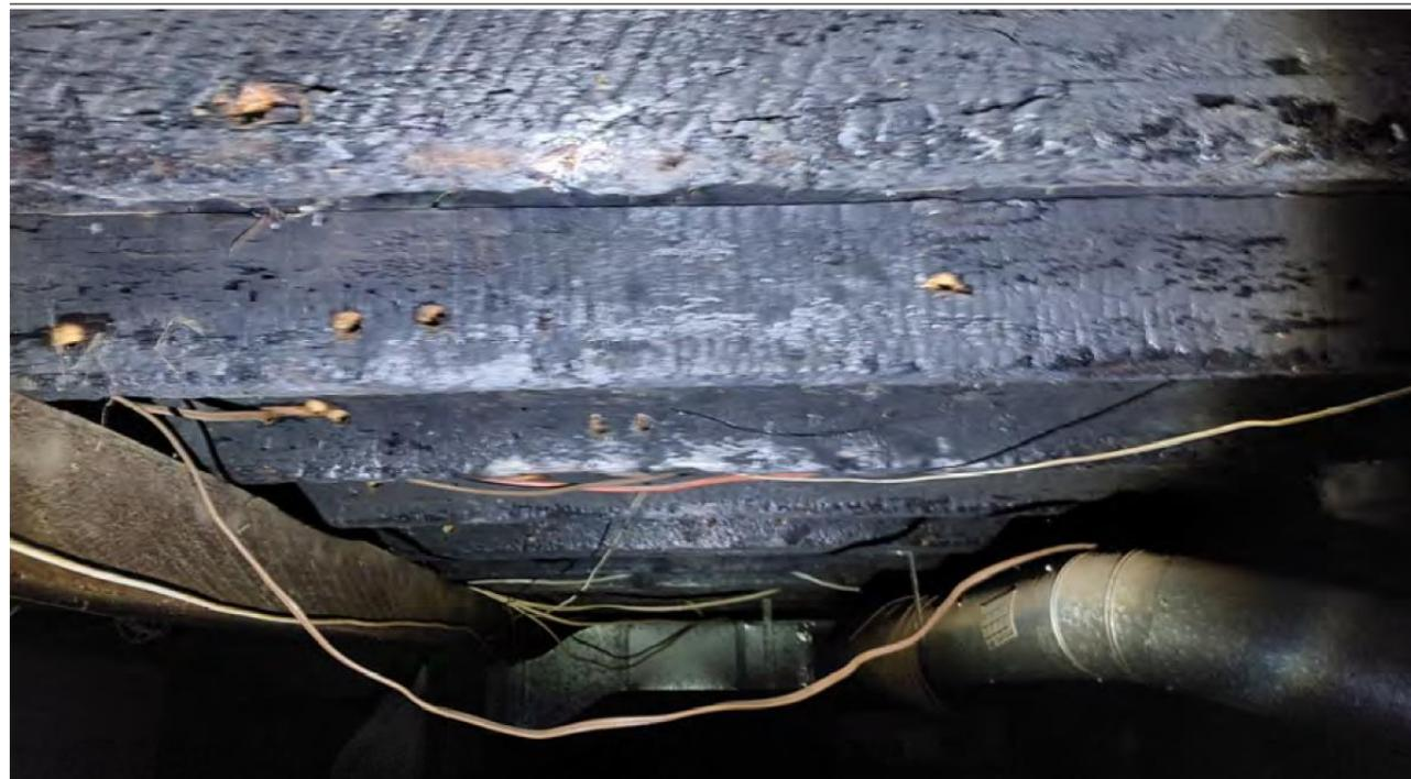
Carbonisation des solives du plancher du rez-de-chaussée
