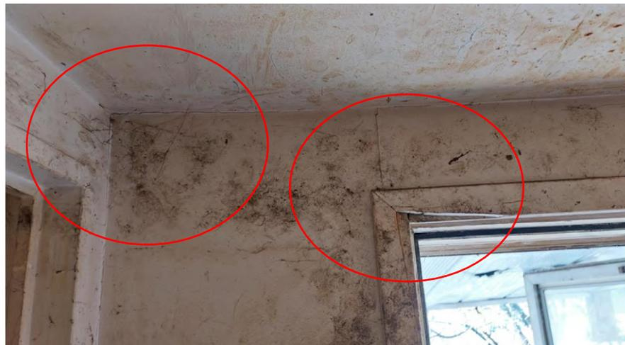
Fissuration au-dessus d'un linteau structural et de la fonction mur/plafond à l'étage
