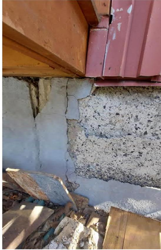
Délaminage et éclatement du mur de fondation Sud
