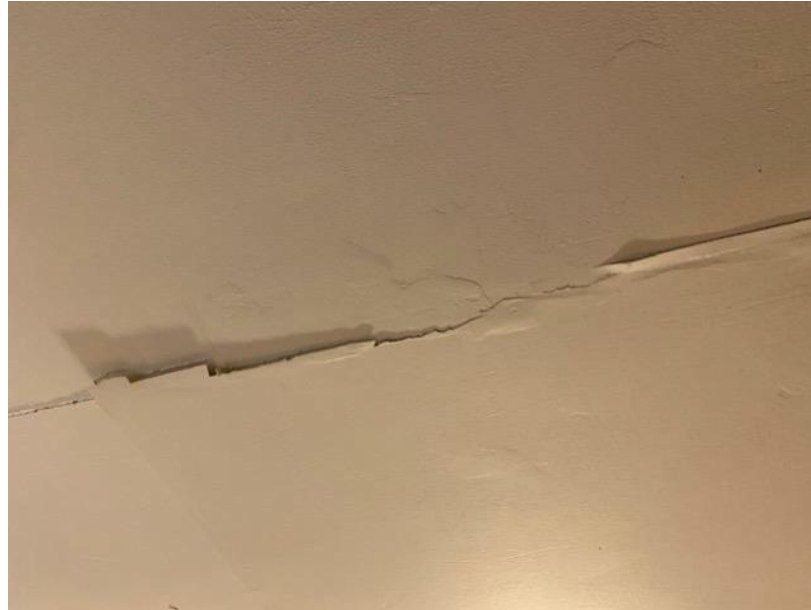
État de mur à l'intérieur
