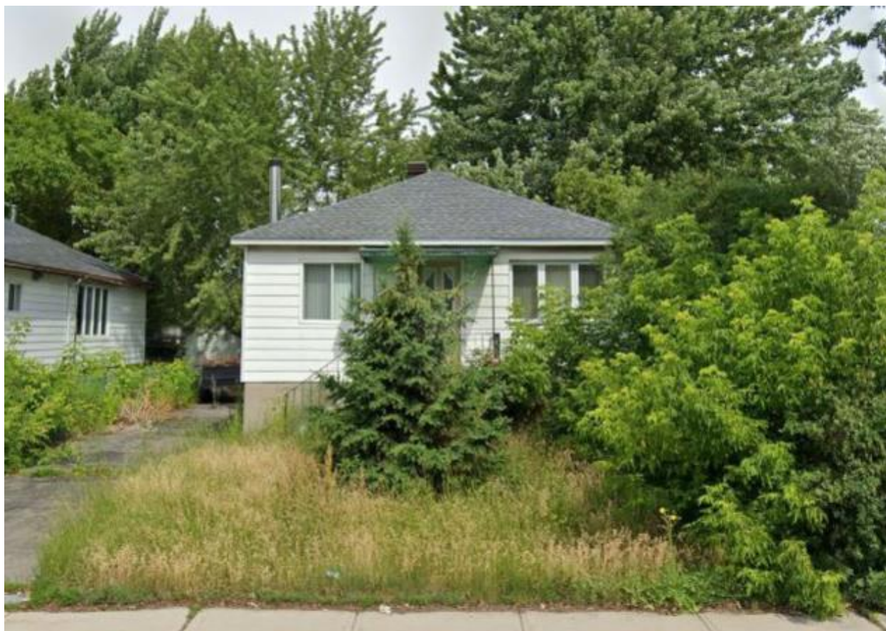
Habitation unifamiliale de structure isolée construite en 1952.
