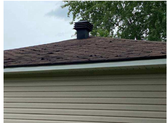
État revêtement de la toiture
