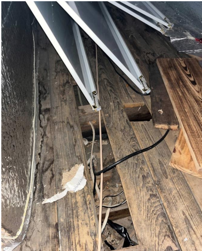
Structure artisanale du plancher du RDC
