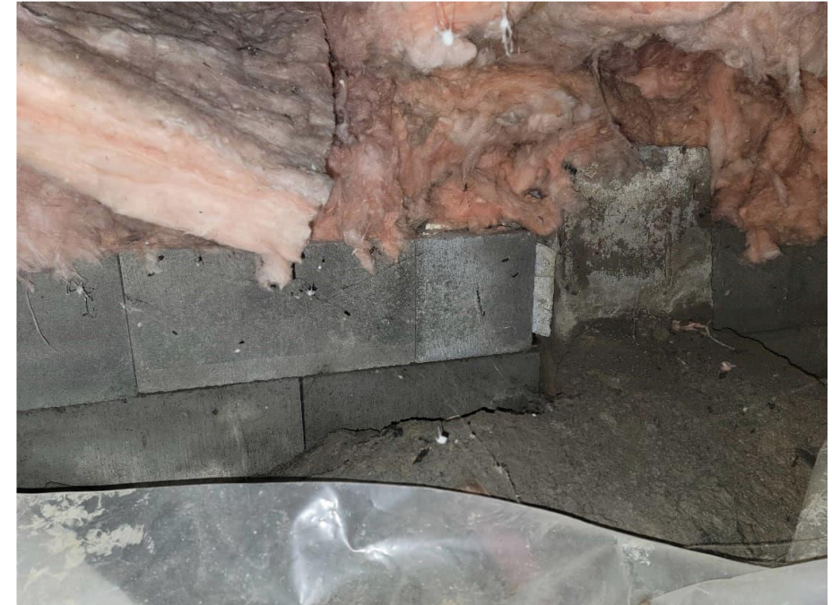
Mur de fondation sans isolants dans le vide sanitaire
