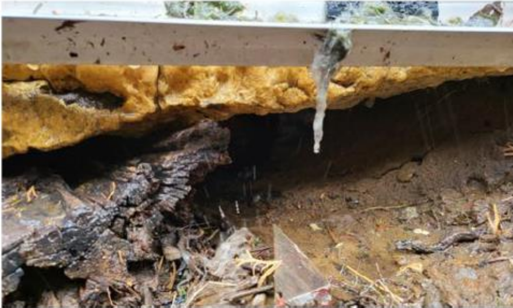
Photo 5 : Ouverture du mur de fondation vers l'intérieur
