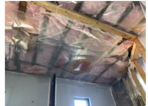
Poche d'eau dans le plafond de l'étage, causée par une infiltration au toit
