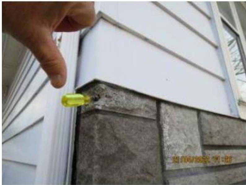
Dégradation de la maçonnerie
