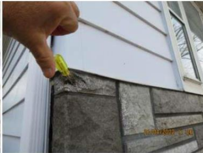
Dégradation de la maçonnerie
