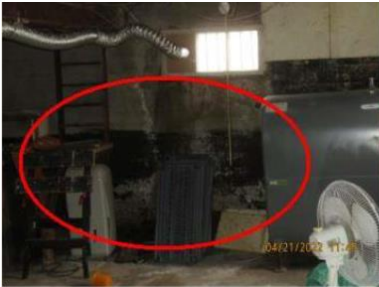
Signes importants d'effritement et de dégradation du béton
