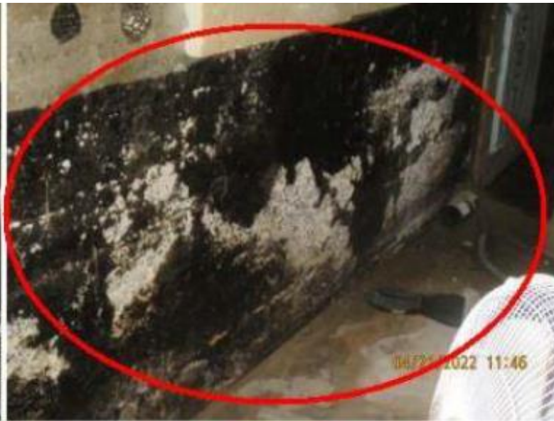
Signes importants d'effritement et de dégradation du béton
