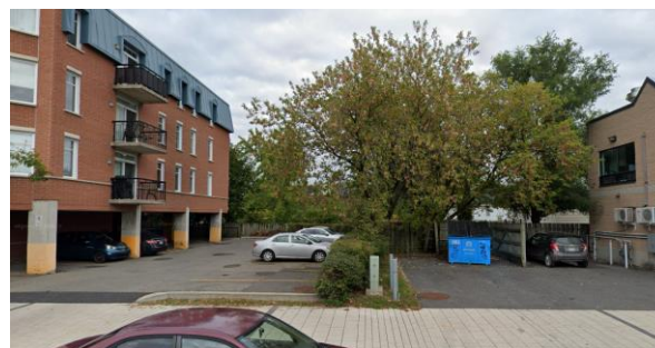
Espaces de stationnement entre les deux bâtiments
