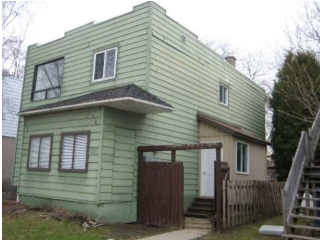
Habitation bifamiliale de structure isolée construite en 1925.
