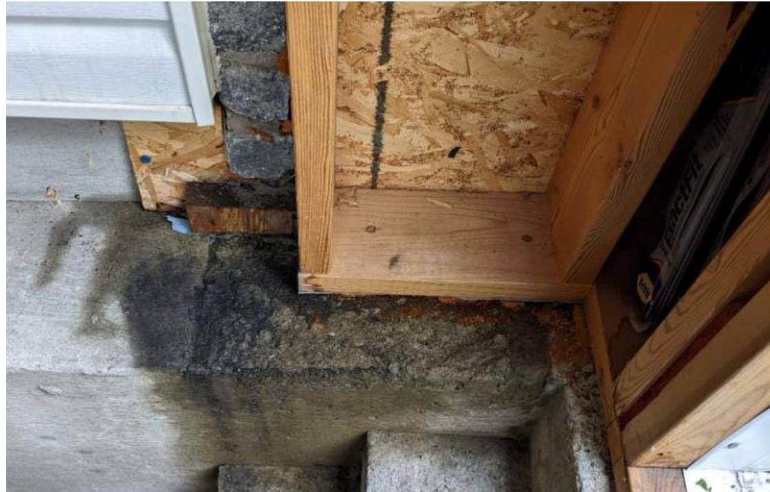
Présence d'infiltration d'eau aux joints avec la construction d'origine
