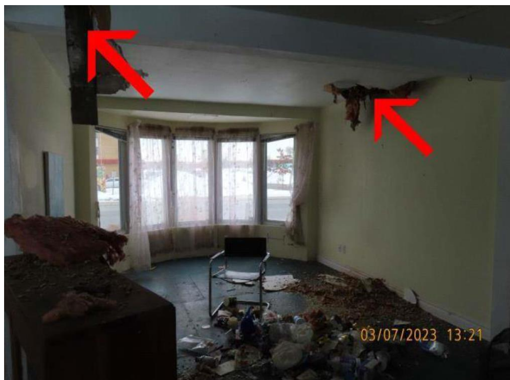
Ouvertures dans le plafond du RDC
