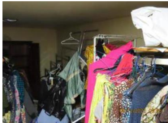
Plusieurs pièces du bâtiment encombrées. Cette situation a limité l'inspection effectuée
