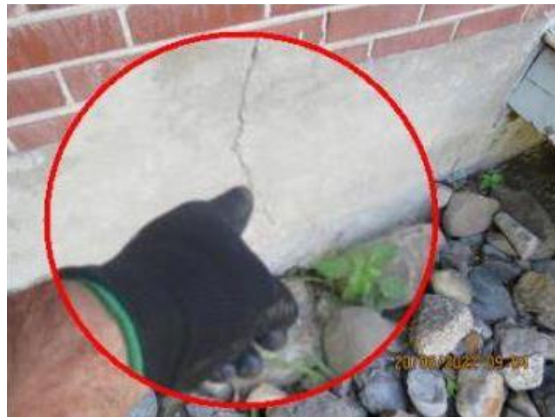
Fissure dans le mur de fondation
