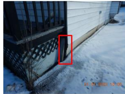
N° 20, Pilier de béton
