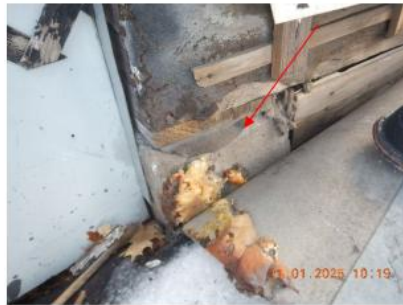
N° 19, Pilier de béton
