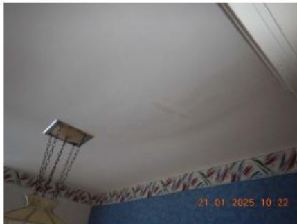
N° 45, Infiltration d'eau
