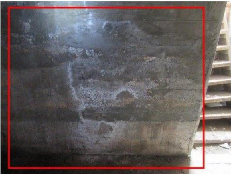
Présence d'efflorescence
