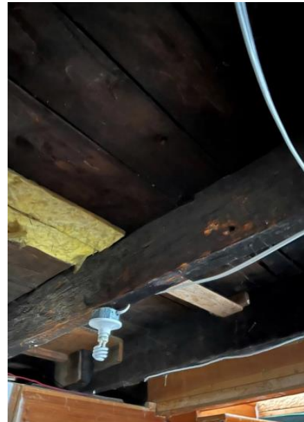
Structure du plancher du RDC affaiblie par la pourriture et l'incendie
