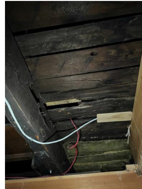
Structure du plancher du RDC affaiblie par la pourriture et l'incendie
