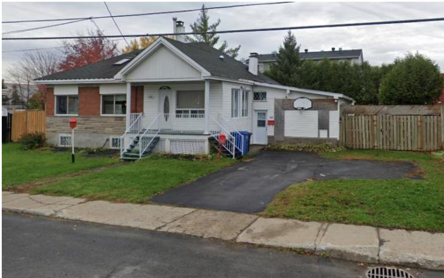
Habitation unifamiliale de structure isolée construite en 1955.
