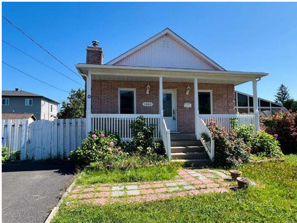
Habitation unifamiliale de structure isolée construite en 1954.
