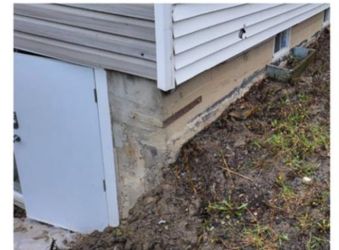
Photo 5 : Coin du mur de fondation abimé et attache métallique rouillée.
