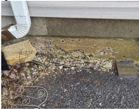
Photo 2 : Agrégats exposés sur le mur de fondation.
