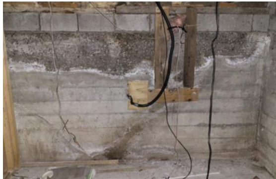
Photo 3 : Agrégats exposés, efflorescence et dépôts de calcium sur le mur de fondation.
