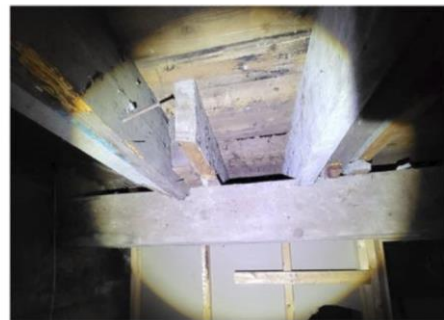
Photo 7 : Solives d'origine fendues et entaillées à l'appui.
