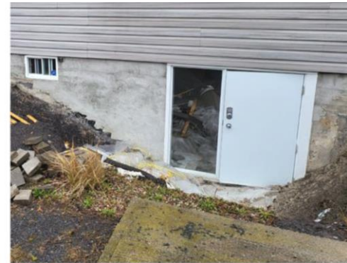
Photo 4 : Descente de sous-sol sans mur de soutènement.
