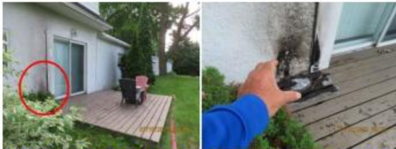
Une portion de la surface du mur est endommagée par ce qui semble un incendie causé par une prise de courant.
