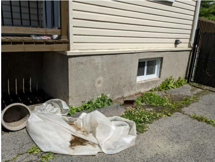
Projection du béton par rapport à l'enveloppe
