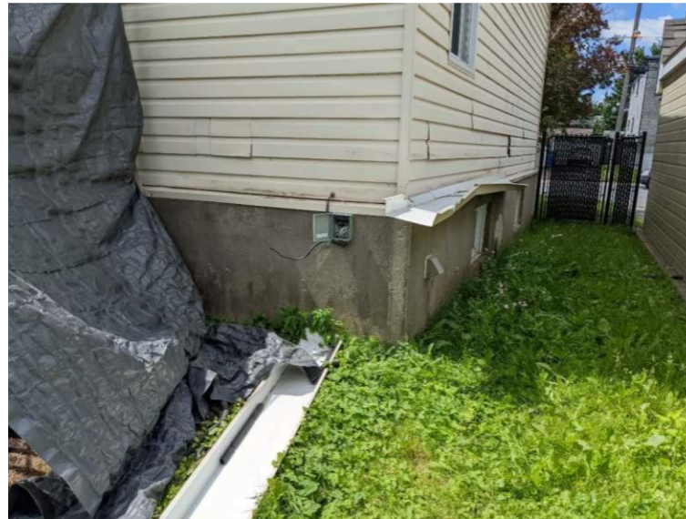
Solin remplacé par une tôle de manière artisanale
