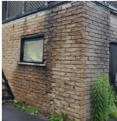
Écaillage de la brique
