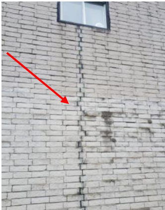
Sectionnement du mur
