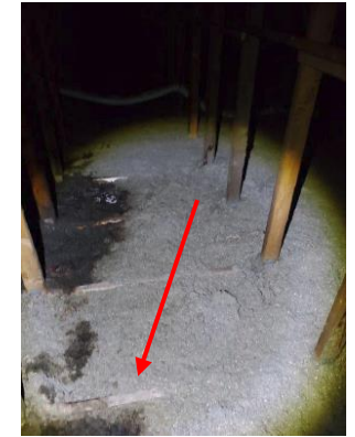
Structure de toiture qui semble être uniquement sur la toiture plate
