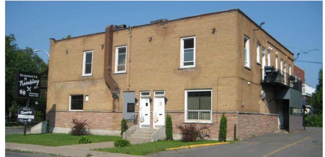
Bâtiment mixte de structure isolée construit sur les fondations et une partie de la structure d'origine de 1900 et 1953 à la suite d'un incendie.
