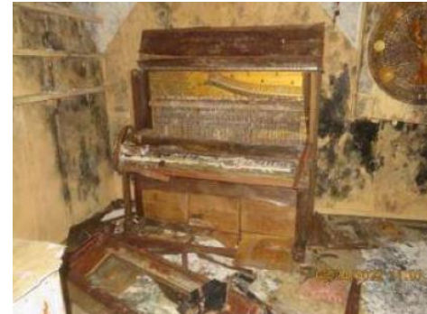
État général de l'intérieur du bâtiment
