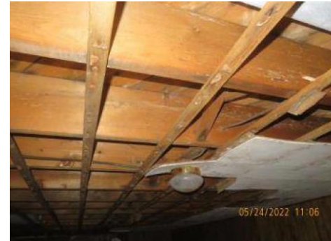
Structure exposée, sans problème apparent
