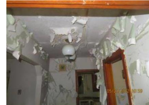
État général de l'intérieur du bâtiment
