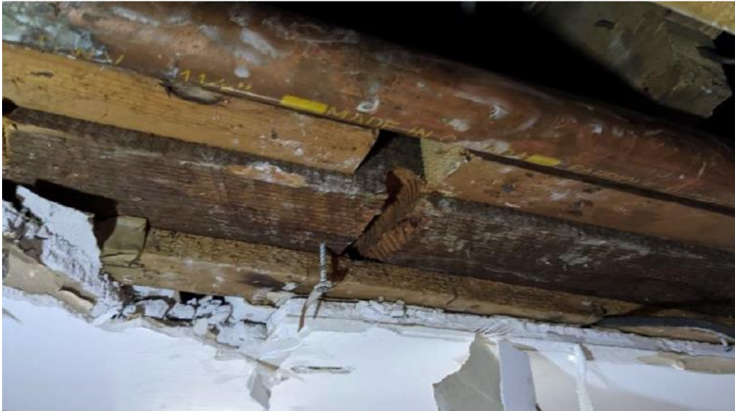
Solives de plancher taillées
