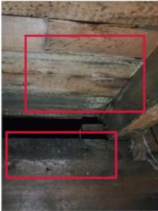
Bois brûlé et traces semblables à de la moisissure sur la structure de plancher
