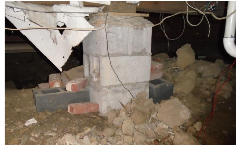
Fondation en blocs de béton
