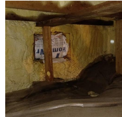
Indice de contamination fongique sur la structure
