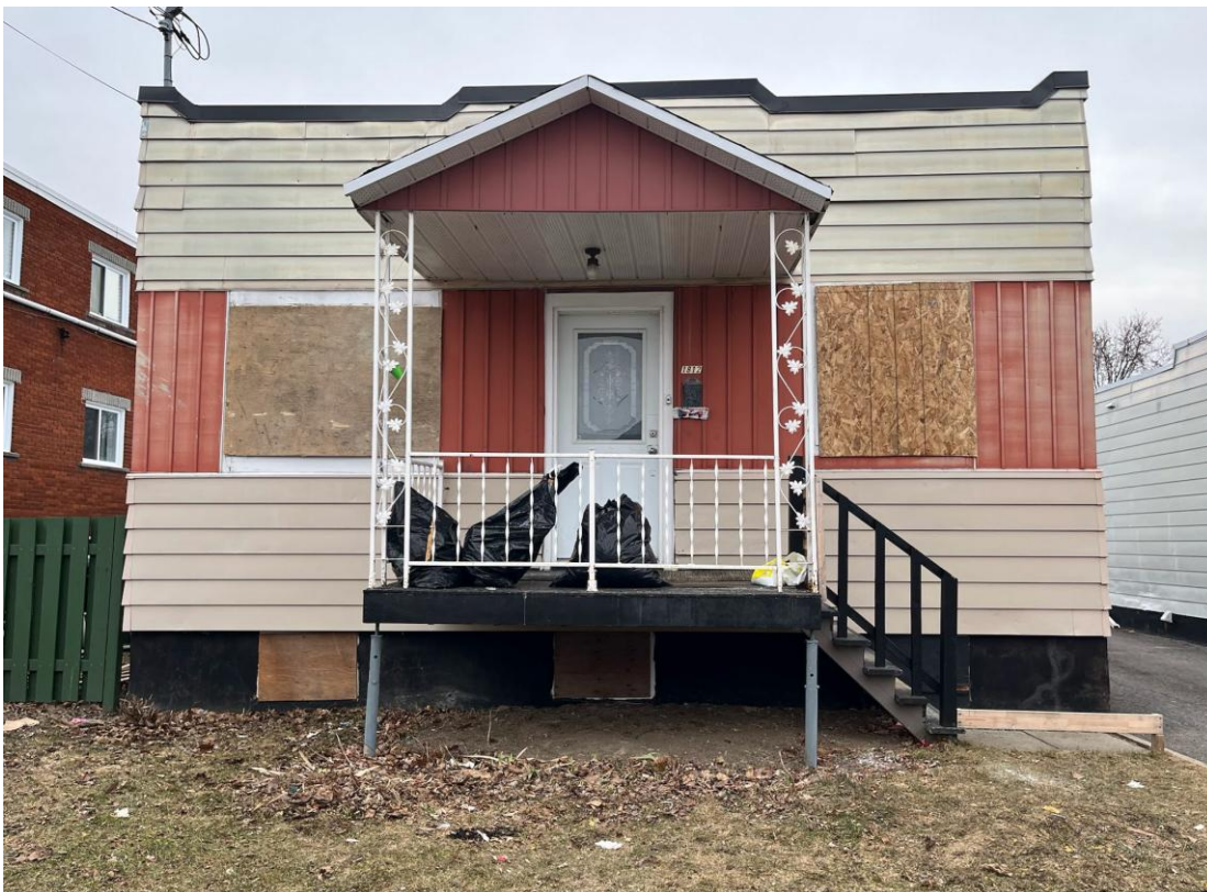
Habitation unifamiliale de structure isolée construite en 1949.
