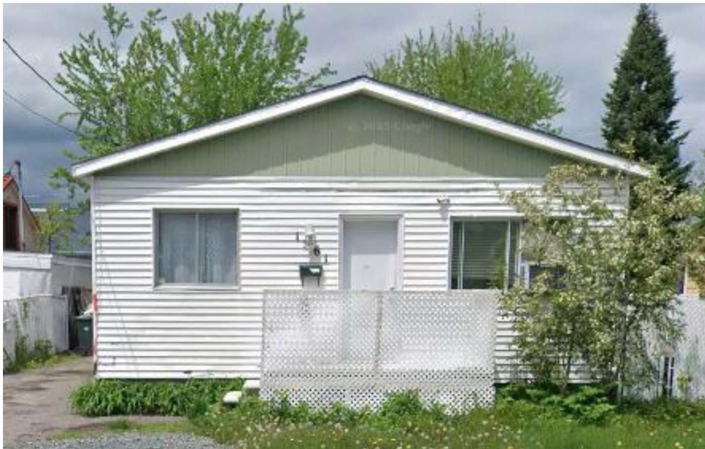
Habitation unifamiliale de structure isolée construite en 1952.
