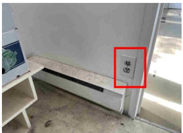
Position non sécuritaire d'une prise de courant
