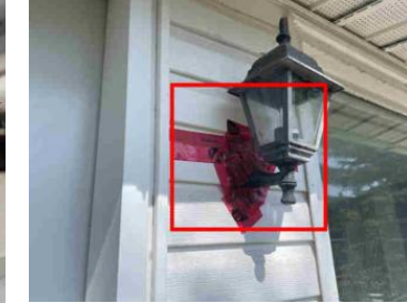
Scellement artisanal d'un luminaire
