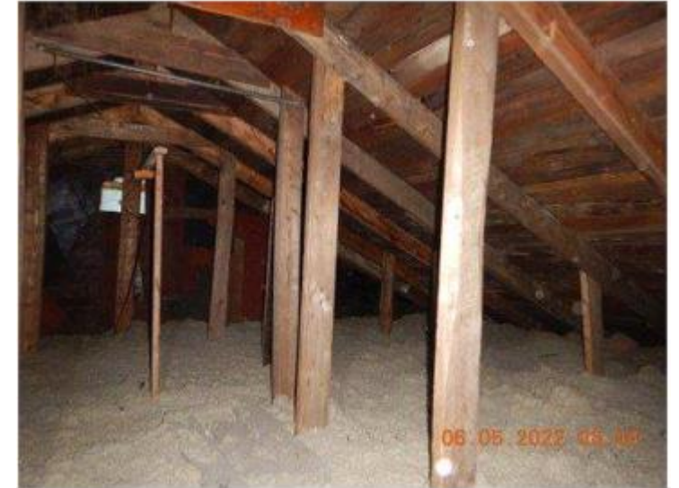
Fléchissement des composantes de la structure de toit (source: Alain Boucher)
