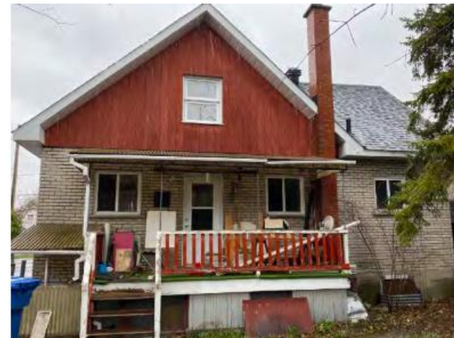
Vue latérale droite et vue arrière de la résidence
