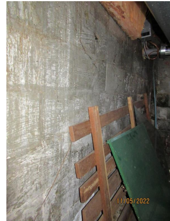
Mur de fondation sans isolants dans le vide sanitaire
