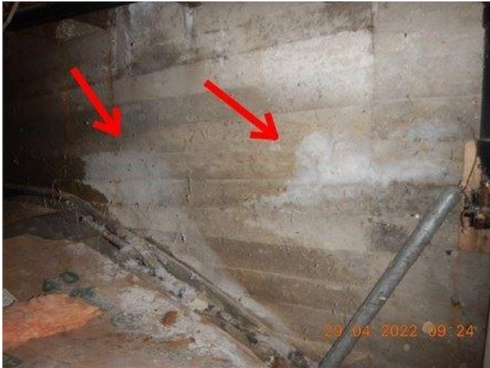
Présence d'efflorescence sur les murs de fondation au sous-sol
