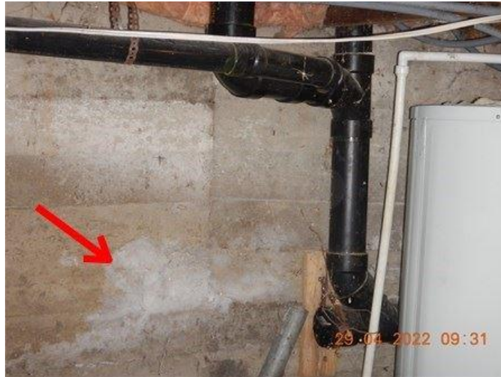
Présence d'efflorescence sur les murs de fondation au sous-sol
