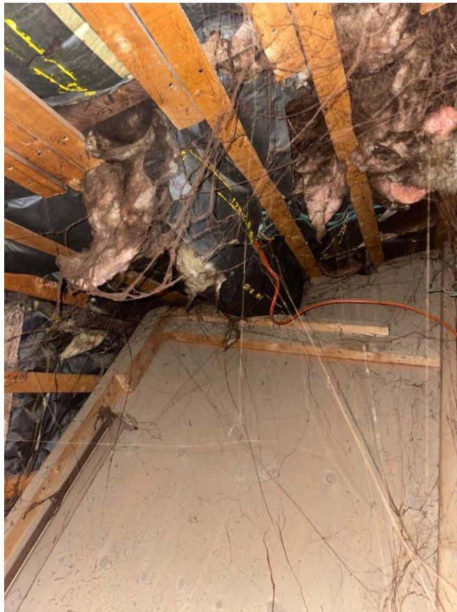
Taches d'humidité sur les fermes et l'isolant
