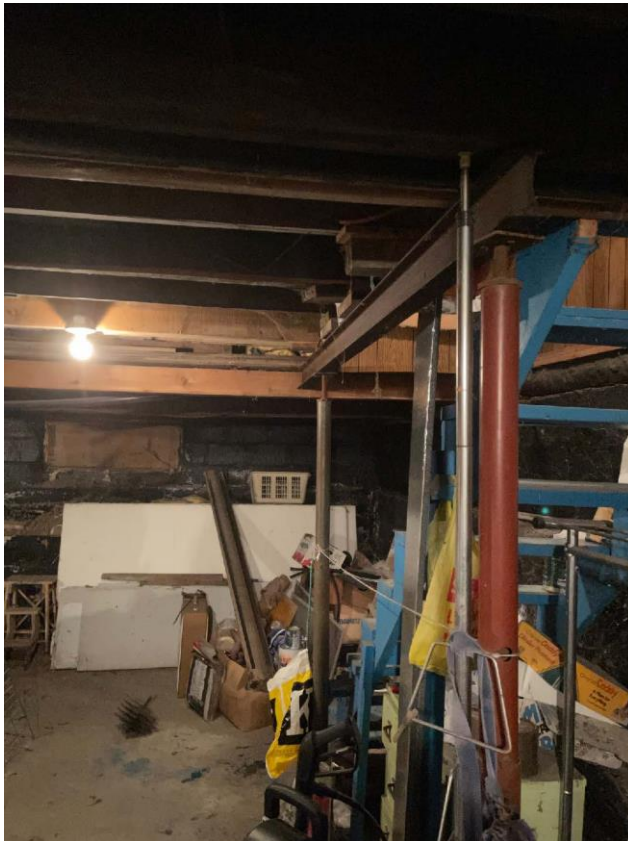
Renfort temporaire de la structure pour limiter les déformations
