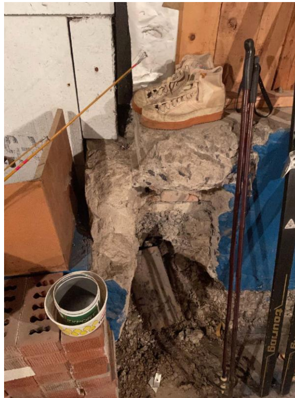
Section de semelle démolie
