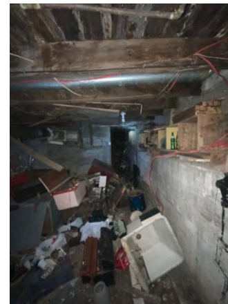
« tablette » de béton sous les fondations d'origine
