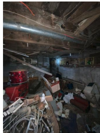
Structure du plancher du rez-de-chaussée
