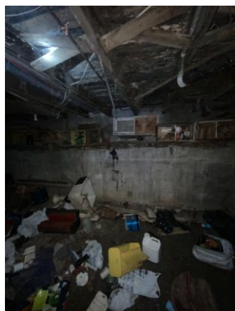
Structure du plancher du rez-de-chaussée fondation arrière
